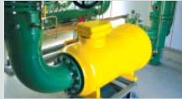
Unna-Königsborn, Zechenstraße: Hier läuft seit Dezember 2003 eine Mikrogasturbine, die Strom und Wärme erzeugt; seit März 2004 eine Entspannungsturbine, die die Druckminderung der Gasversorgung zur Stromerzeugung nutzt.
