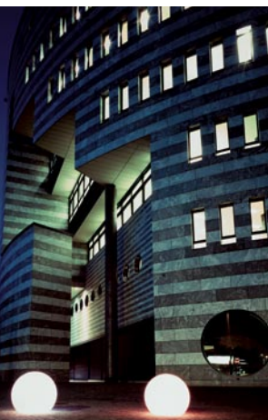
Ist die Beleuchtung energiesparend? Der Ökocheck bringt es zutage
